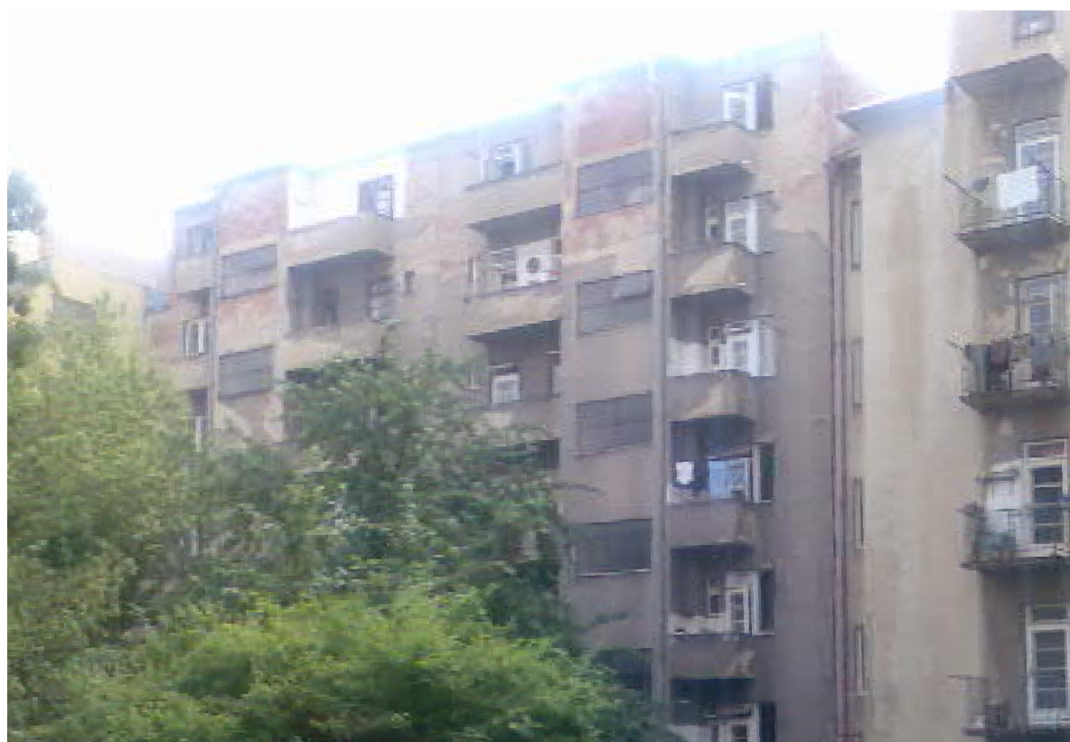
STÁVAJÍCÍ STAV - POHLED ZE DVORA
