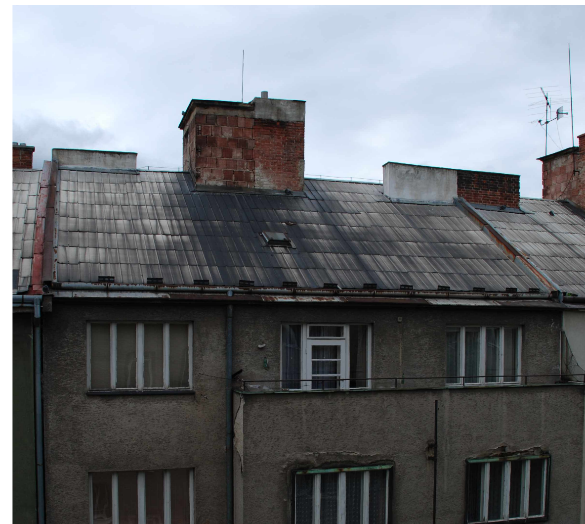
STÁVAJÍCÍ STAV - POHLED Z PROTĚJŠÍHO DOMU
